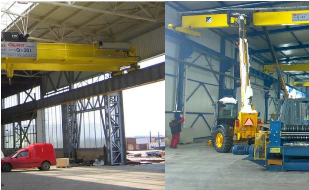
Slika 7.8-Spregovi za kočenje u industrijskoj hali
