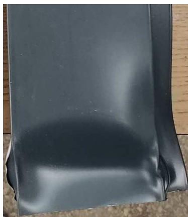
Rys. 6.8 Lokalna utrata stateczności w strefie przypodporowej
