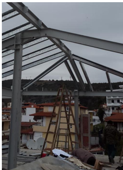
Εικ.11: Επέκταση κτηρίου με μεταλλικό σκελετό στη Χαλκιδική
