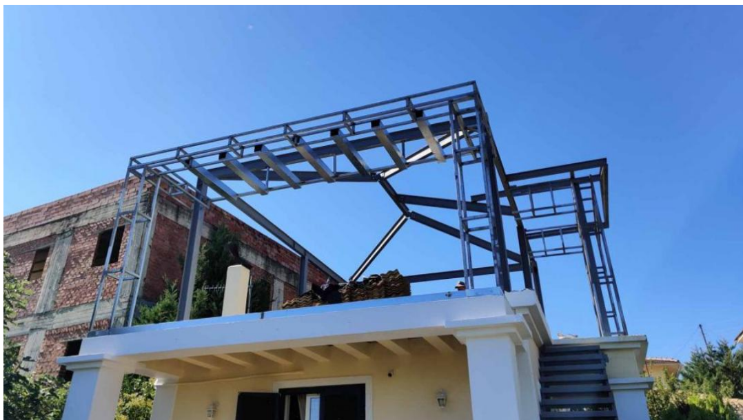
Εικ.15: Μεταλλικός φορέας επέκτασης κτηρίου στη Κέρκυρα
