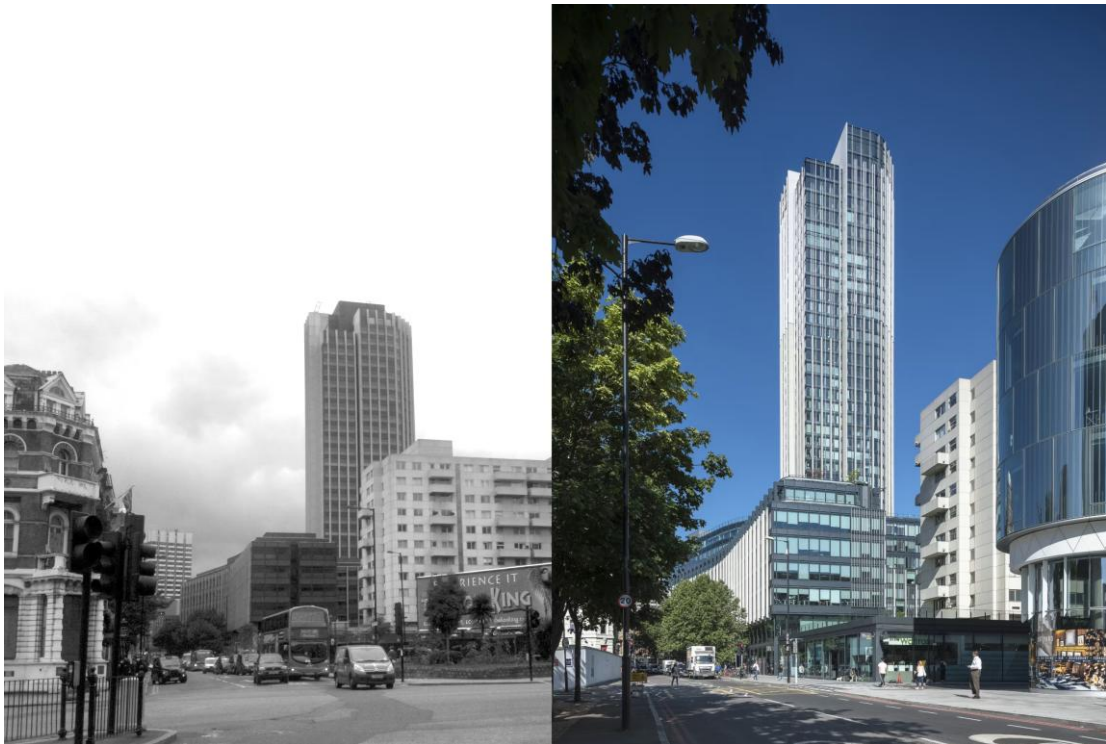
Εικ.7: Πύργος Southbank, προσθήκη 11 ορόφων χαλύβδινου σκελετού
