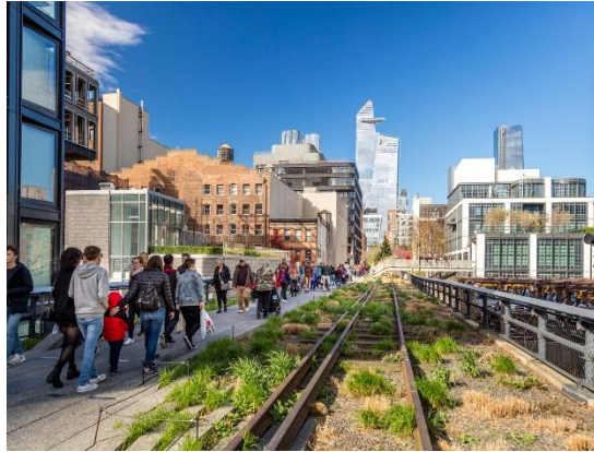
Εικ.8: Μετατροπή και επέκταση σιδηροδρομικής γραμμής σε αστικό χώρο
