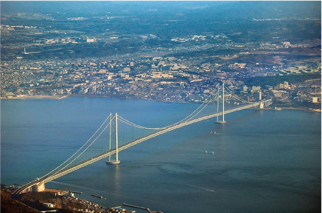
Figura 30 - Il Ponte dello stretto di Akashi è il ponte sospeso più lungo del mondo. È alto 282,8 m e lungo 3911 metri. La sua campata principale è lunga ben 1991 metri. Inaugurato il 5 aprile 1998, unisce la città di Kobe sull'isola di Honshū all'isola Awaji, passando al di sopra dello stretto di Akashi, realizzato da Honshu Shikoku Bridge Authority, dal 1988 al 1998.
