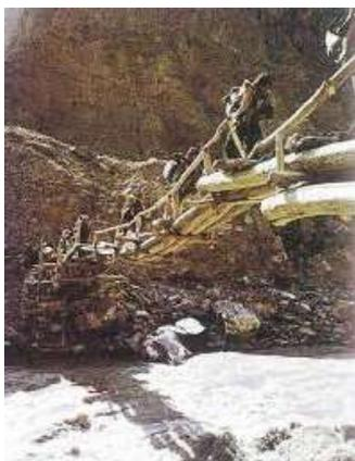
Figura 1 - Primitivo ponte "a sbalzo" (cantilever) realizzato in Nepal.
