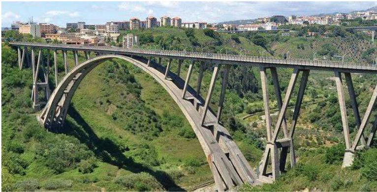
Figura 15 - Il ponte Bisantis (denominazione ufficiale: Viadotto Bisantis, detto anche Ponte Morandi, Viadotto sulla Fiumarella o, in dialetto catanzarese, "U punta 'e Catanzaru" o "U punta subb'a Hjumareddha") è un ponte ad arco stradale e pedonale, composto da un'unica carreggiata e da 3 corsie, due in direzione SO e una in direzione NE, costruito su una sola arcata in calcestruzzo armato (C.A.)
