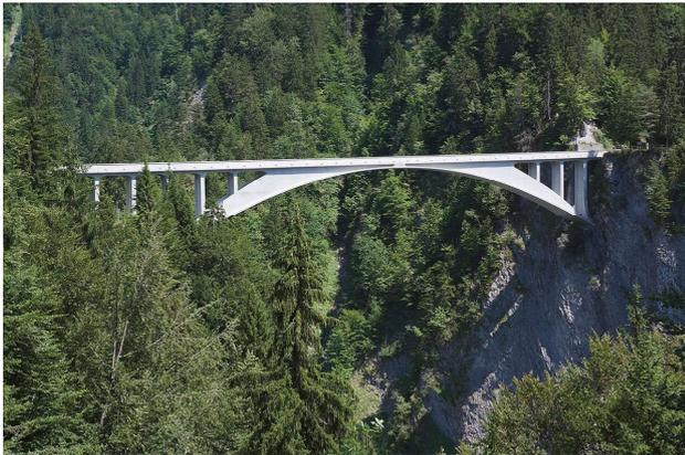
Figura 13 - Il viadotto Salginatobel (ted. Salginatobelbrücke) è un ponte ad arco, in calcestruzzo armato, che varca una profonda gola nel territorio comunale di Schiers, nel cantone svizzero dei Grigioni. Progettato da Robert Maillart tra il 1928-1930.
