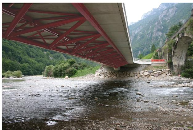
Figura 91 Vista sottostante il ponte, inquadramento del sistema a travata reticolare
