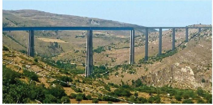
Figura 18 - Il ponte passa sulla valle del fiume Irminio tra le città di Ragusa e Modica. È composto da una serie di pilastri in calcestruzzo e campate traverse in acciaio. Realizzato dal progettista Riccardo Morandi nel 1975-1984.
