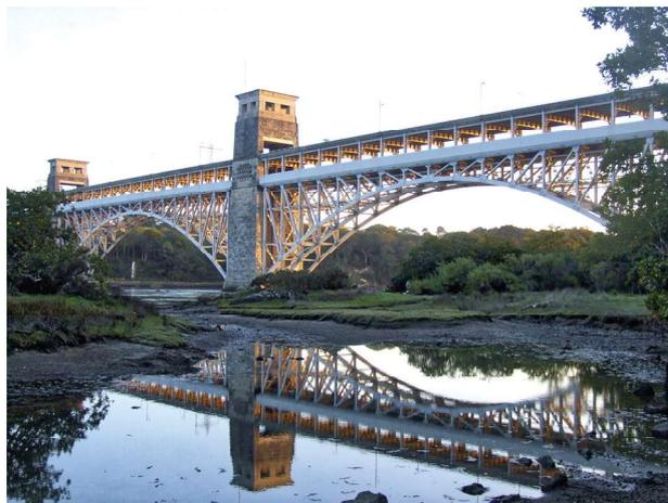
Figura 12 - Il Britannia Bridge è un ponte sullo Stretto di Menai tra l'isola di Anglesey e la terraferma del Galles. Recupero strutturale a seguito di un disastroso incendio avvenuto nel 1966.
