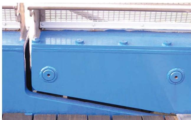
Figura 85 Giunto di dilatazione con schema a patino che vincola a flessione l'impalcato
