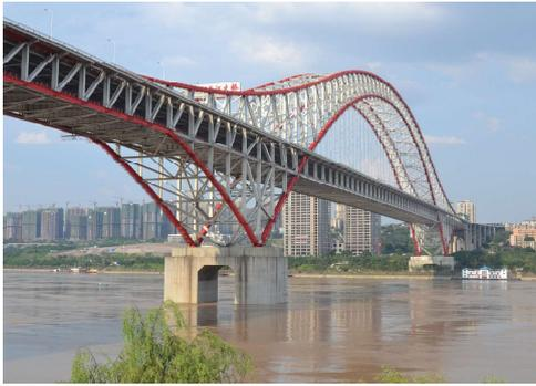
Figura 19 - Il Ponte Chaotianmen è un ponte stradale e ferroviario sul Fiume Azzurro nella città di Chongqing, nella Cina centro meridionale. Al 2019 è il ponte ad arco a via intermedia in acciaio più lungo del mondo, con una luce di 552 metri. Realizzato dal 2004 al 2009.
