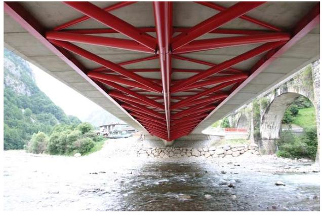
Figura 93 Vista sottostante il ponte, inquadramento del sistema a travata reticolare
