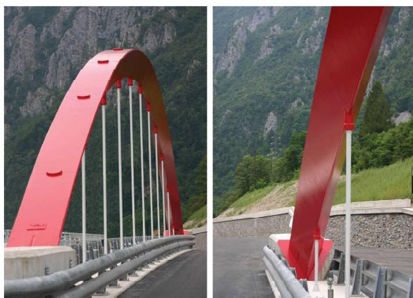
Figura 90 vista globale (sinistra) dell’arco strallato, (a destra) dettagli stralli
