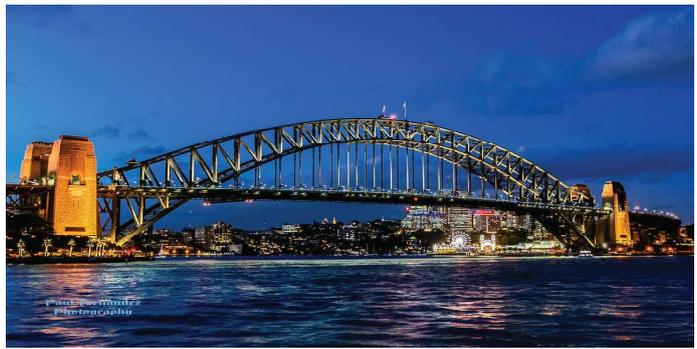
Figura 20 - Il Sydney Harbour Bridge (in italiano noto anche come il ponte di Sydney) è un ponte ad arco con piano stradale sospeso situato a Sydney in Australia. Il ponte collega il quartiere degli affari di Sydney con l'area settentrionale della città, North Shore, attraversando nella sua lunghezza la baia di Sydney, costituita dalla foce del fiume Parramatta. Realizzato dal 1923 al 1932.
