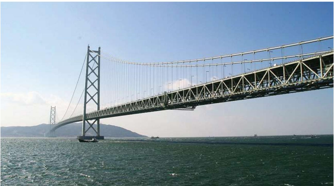
Figura 29 - Il Ponte dello stretto di Akashi è il ponte sospeso più lungo del mondo. È alto 282,8 m e lungo 3911 metri. La sua campata principale è lunga ben 1991 metri. Inaugurato il 5 aprile 1998, unisce la città di Kōbe sull'isola di Honshū all'isola Awaji, passando al di sopra dello stretto di Akashi, realizzato da Honshu Shikoku Bridge Authority.
