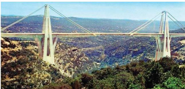
Figura 23 - Il ponte sul Wadi al-Kuf è un ponte strallato stradale costruito in calcestruzzo armato precompresso e progettato da Riccardo Morandi nel 1967-1971.
