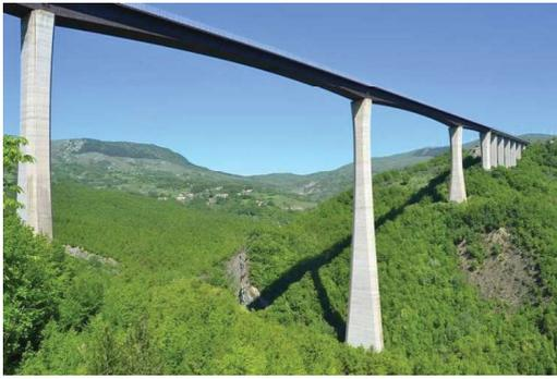
Figura 17 - Il ponte fa parte dell'autostrada del Brennero (lato austriaco: Brennerautobahn A13) e con la sua altezza dal fondo valle di 190 metri è uno dei ponti più alti d'Europa. Realizzato tra il 1960-1963.
