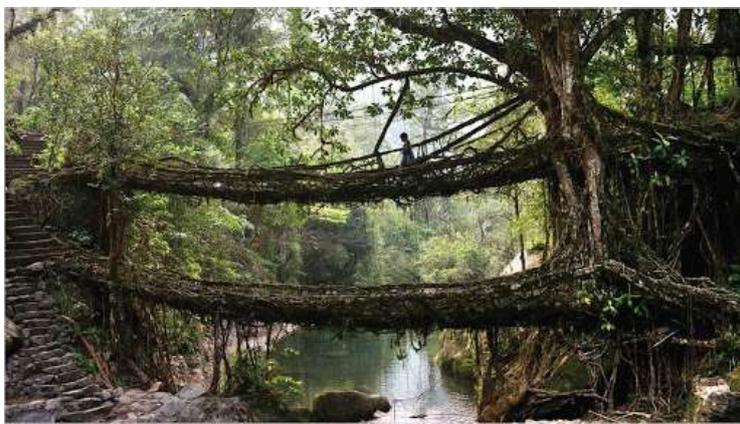
Figura 2 - Primitivo ponte sospeso realizzato in India mediante radici di fico banyan dal popolo Khasi.
