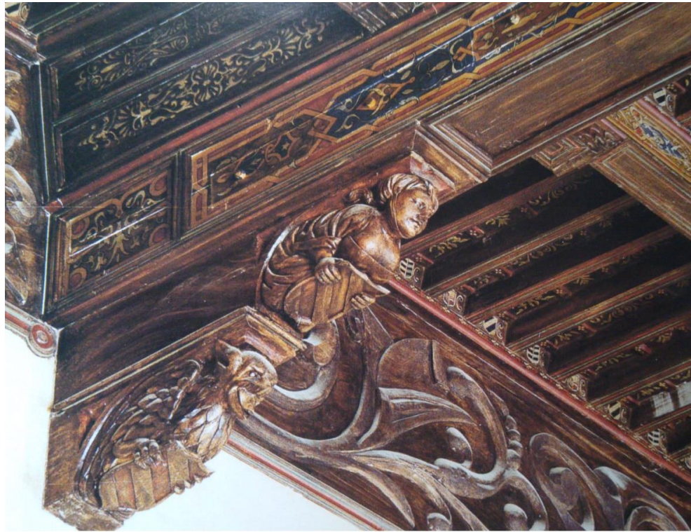
Forjado de Palacio Duques de Híjar, provincia de Zaragoza.
