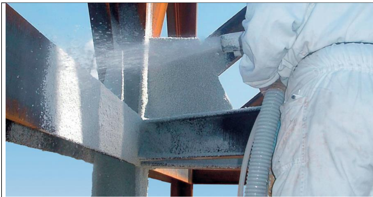
Rys. 3-7. Sposób aplikowania systemu natryskowego zaprezentowany w katalogu produktu mrc Tecwool F.
