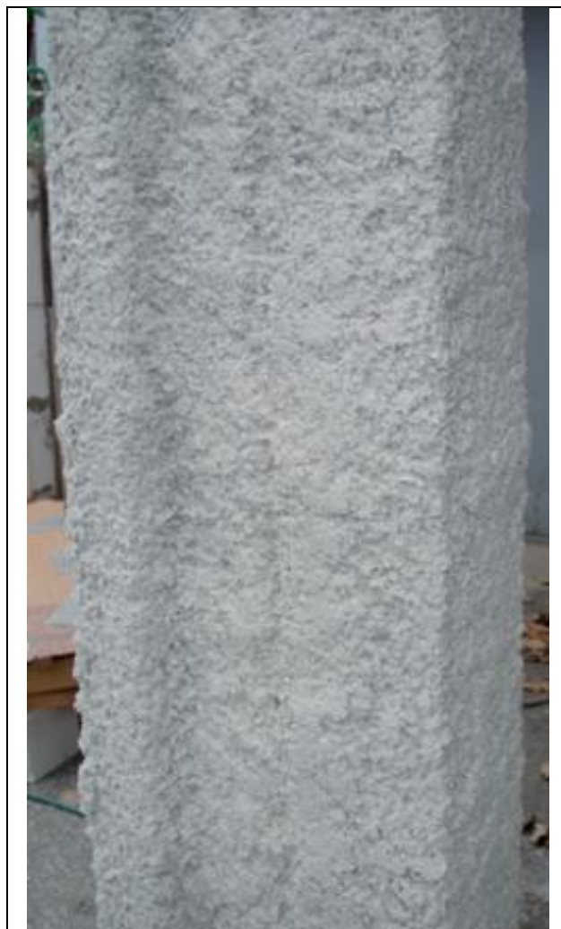
Rys. 3-6. Sposób zabezpieczenia słupa zaprezentowany w katalogu produktu mrc Tecwool F.
