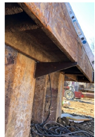
Figure 14 Représentation d'une lierne avec son équerre en acier
