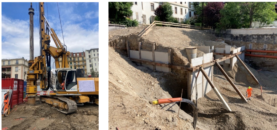
Figure 3 Parois berlinoise : démarrage - fin
