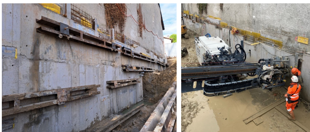
Figure 4 Chantier d'ancrage : démarrage- fin
