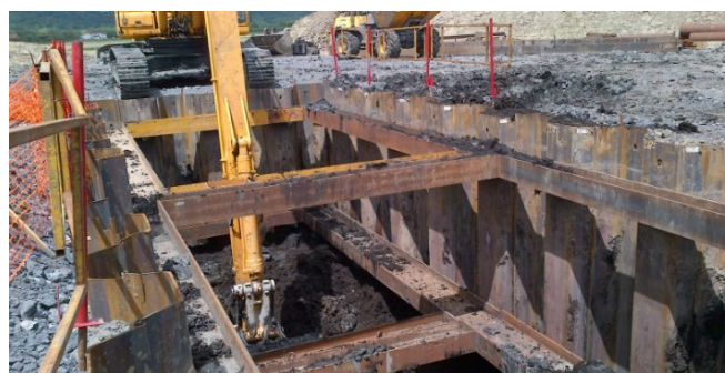
Figure 16 Système par butonnage
