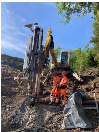
Figure 6 Chantier petit forage : forage d'un piézomètre
