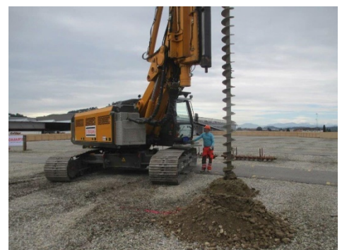
Figure 12 Exemple de forage d'ameublissement avec tarière
