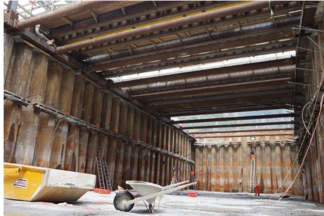
Figure 8 Exemple d'une fouille en palplanche
