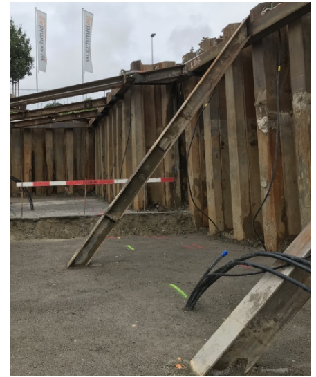
Figure 15 Représentation d'une béquille de soutènement
