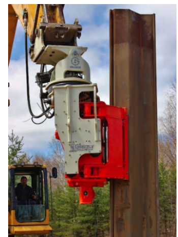
Figure 10 Le vibro-fonçage
