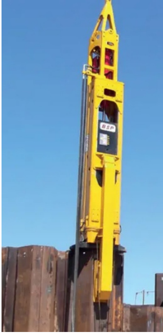
Figure 9 Outils utilisé pour le battage : le marteau
