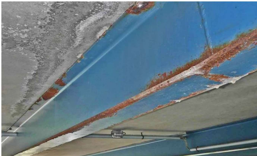
Abbildung 4: Korrosion eines Trägers (Vijayagopal, et al., 2023)
