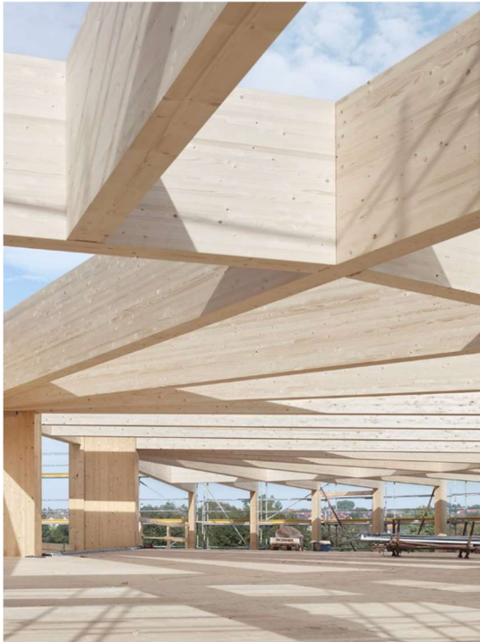
Abbildung 9: Konstruktion Parkhaus Wendlingen (Birnbaum, 2024)
