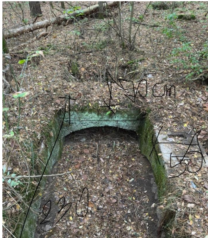
Rys. 2.8. Tunel techniczny z wymiarami – źródło własne
