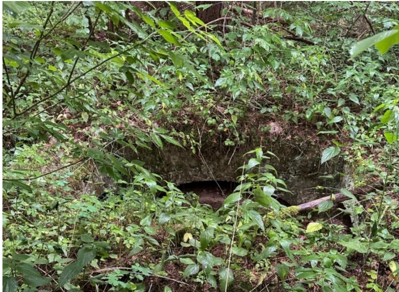
Rys. 2.9. Tunel techniczny przy bramie wjazdowej do hangaru – źródło własne
