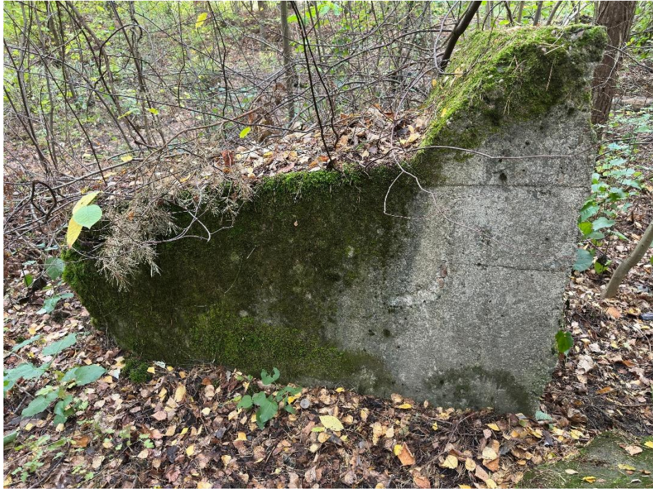
Rys. 2.5. Fundament (wewnętrzny) odtwarzanego hangaru, – źródło własne
