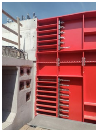
Obr. 2 Kotvení krakorce do betonového průřezu komorového mostu
