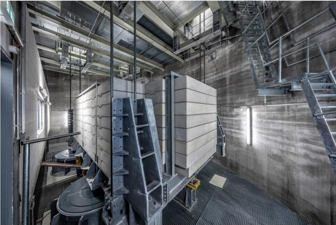
Abbildung 6: Das Schwingungsdämpfersystem im Testturm RW (Bischoff et al. 2020)
