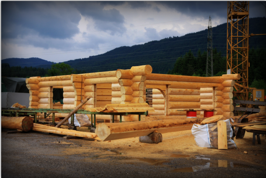
Bild 3: BV Rumberg Blockbau
