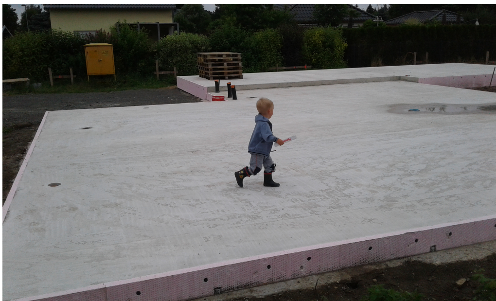
Bild 129: Ausgeführte Bodenplatte (Beispiel 2 Kapitel 3)
