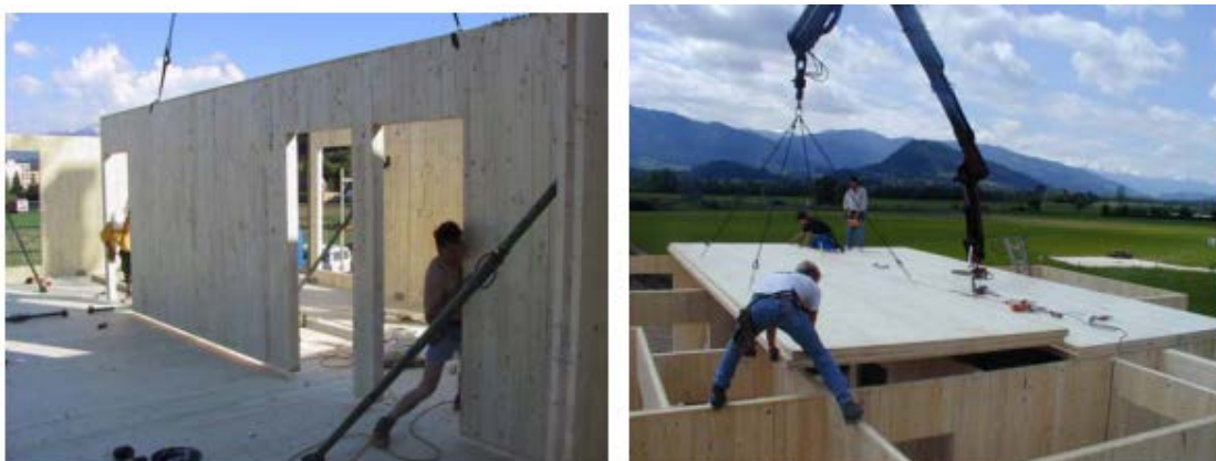
Figura 3.17 Montaggio di un elemento di parete (a sinistra) e di solaio (a destra) di pannello di legno compensato di tavole [7].
