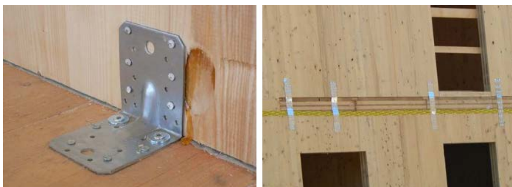
Figura 3.82 Angolare metallico di collegamento fra la parete ed il sottostante solaio (a sinistra) e bande forate sul lato esterno dell'edificio (a destra) [23].
