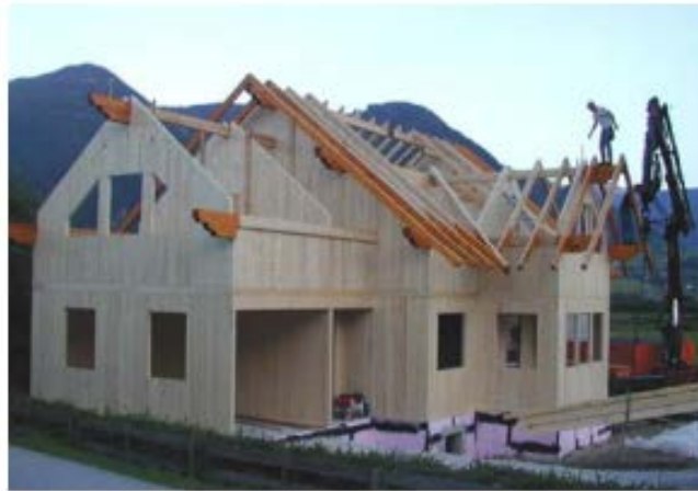
Figura 3.11 Impiego dei pannelli di legno compensato di tavole nell'edilizia residenziale [7].
