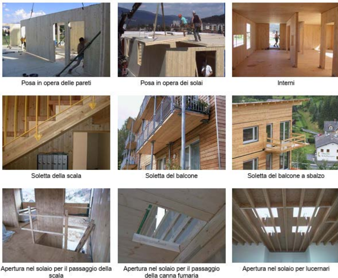
Figura 3.55 Impiego di pannelli X-Lam nell'edilizia residenziale [12].
