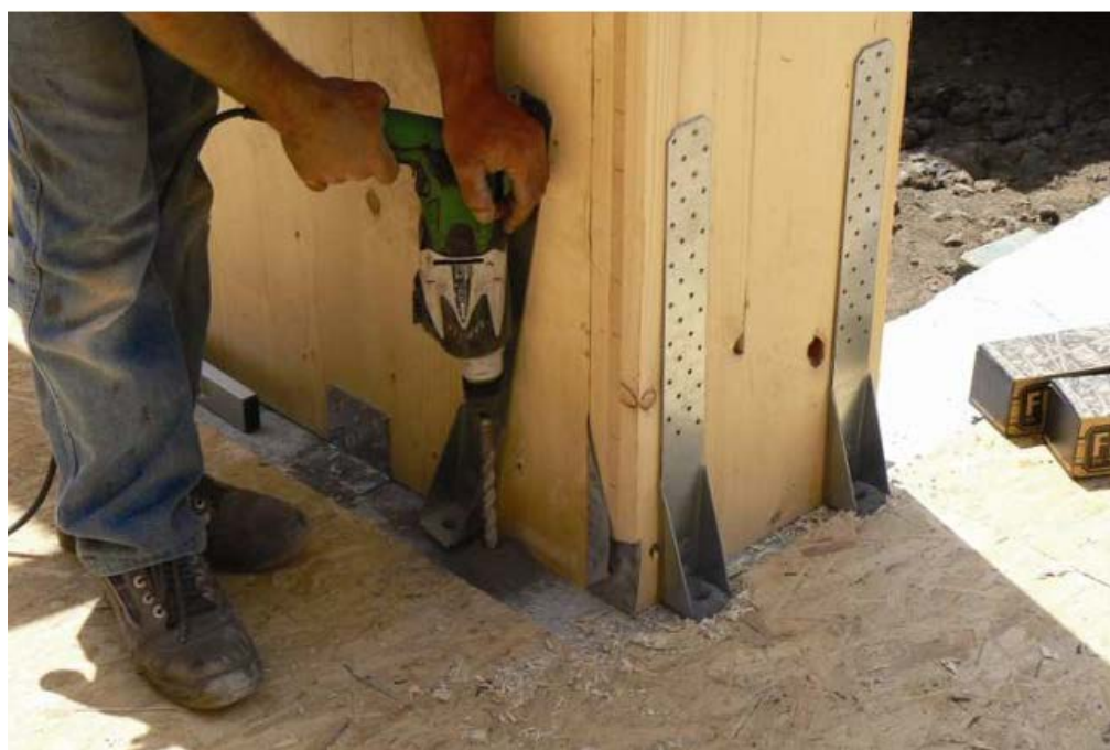
Figura 3.61 Hold-down sugli spigoli dell'edificio ed in corrispondenza delle aperture, di presidio al sollevamento [23].
