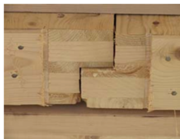
Figura 3.99 Giunto longitudinale a cerniera fra due pannelli X-Lam costituenti il solaio [12].
