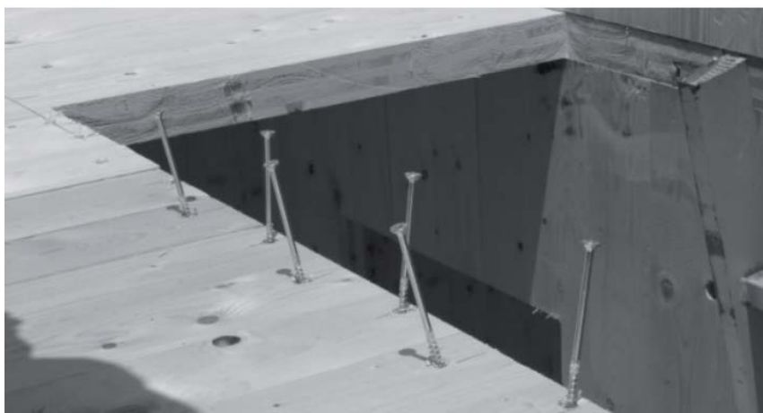
Figura 2.7 Viti auto-foranti per collegamento solaio-pareti in un edificio a pannelli portanti [1].
