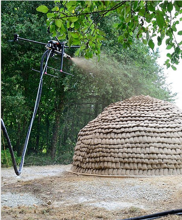
89. Empleo del dron en la construcción. Proyecto: Mud shell desingjuction. Inglaterra
