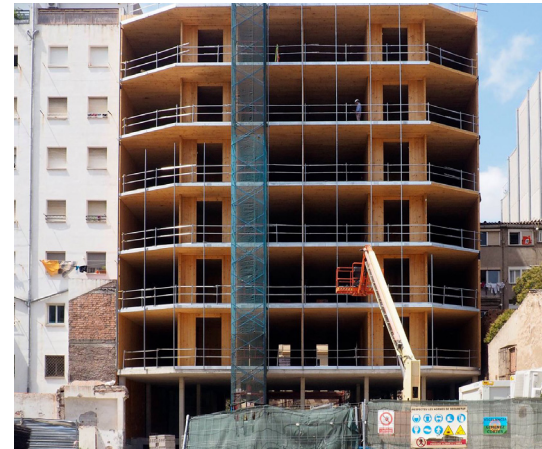
45 Estructura de CLT del proyecto "La Borda". Barcelona - España.
