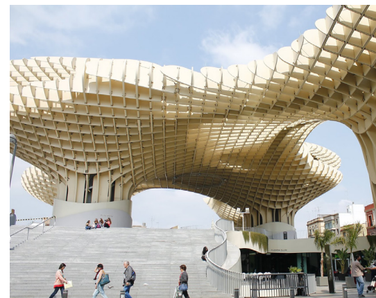
47. Estructura de LVL en las "Setas de Sevilla". Sevilla - España.
