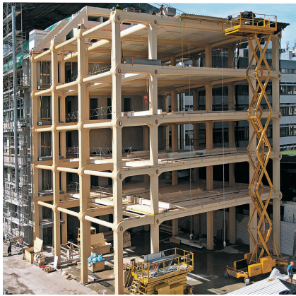
41 y 42. Estructura de madera laminada encolada del edificio "Tamedia Center" en Zurich - Suiza.
