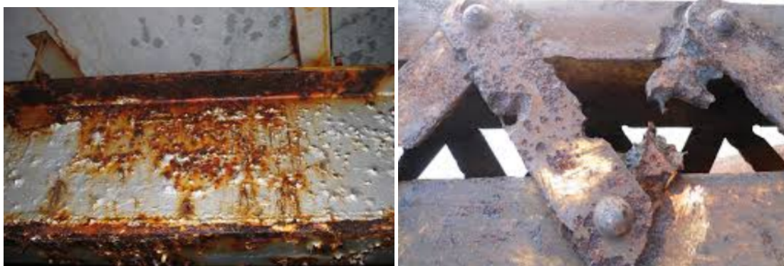
Figura 24: Corrosione su acciaio da carpenteria
