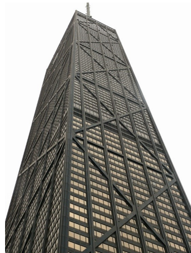
Figura 12: John Hancock Center - Chicago (Sistema strutturale a tubo controventato)
