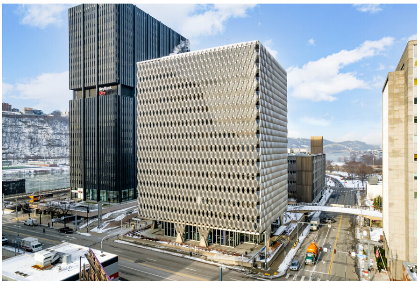
Figura 13: IBM Buildign - Pittsburgh (Sistema strutturale diagrid)
