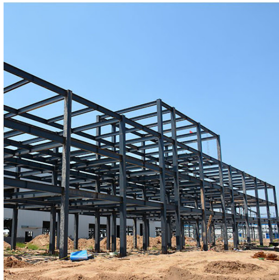
Figura 9: Sistema strutturale a telaio
