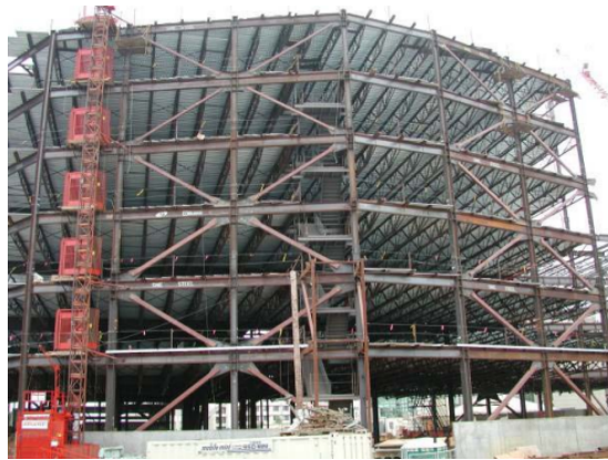
Figura 10: Sistema strutturale a telaio controventato
