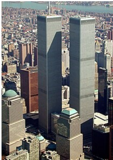
Figura 11: World Trade Center - New York (Sistema strutturale a tubo esterno)
