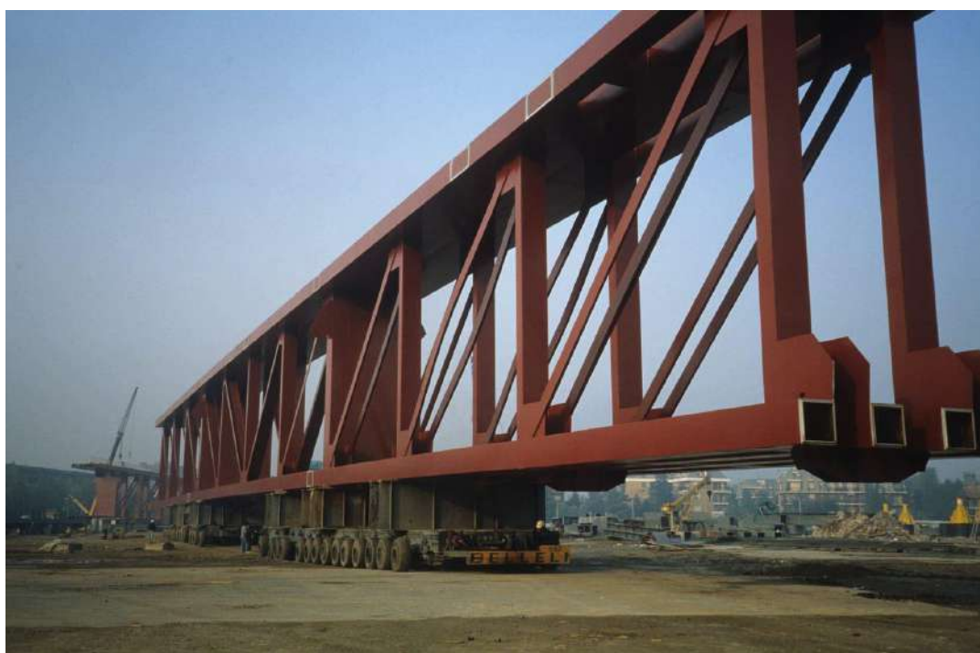
Rys. 1.11. Zdjęcie ukazujące pojedynczy element kratownicy pierwszorzędnej wchodzącej w skład stadionu San Siro w Mediolanie, [15]
