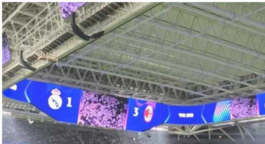
Rys. 1.22. Zdjęcie przedstawiające zamknięty dach w trakcie meczu na stadionie Santiago Bernabéu, Madryt, Hiszpania [zdj. autorskie]
