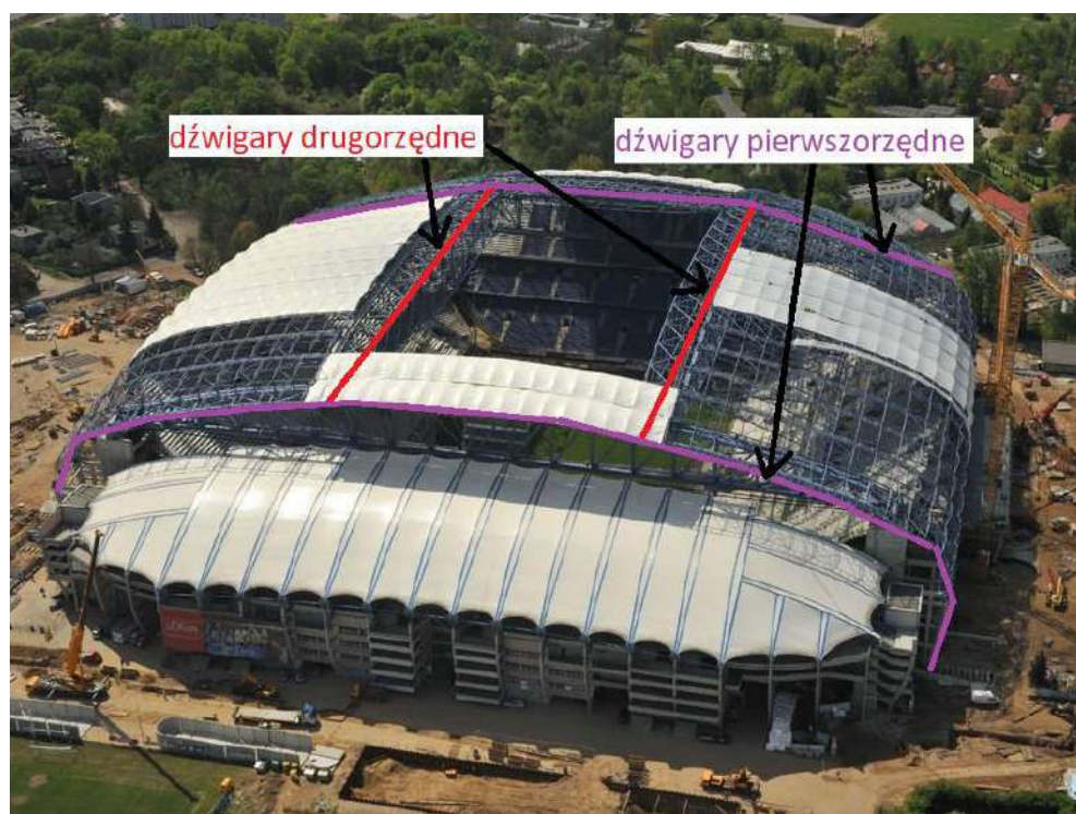
Rys. 1.8. Zdjęcie wykonane podczas budowy Stadionu Miejskiego w Poznaniu z widocznymi dźwigarami kratowymi
