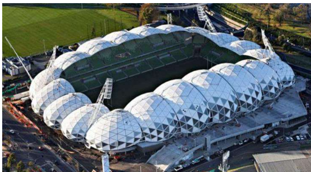
Rys. 1.17. Zdjęcie przedstawiające stadion AAMI Park w Melbourne, Australia [11]
