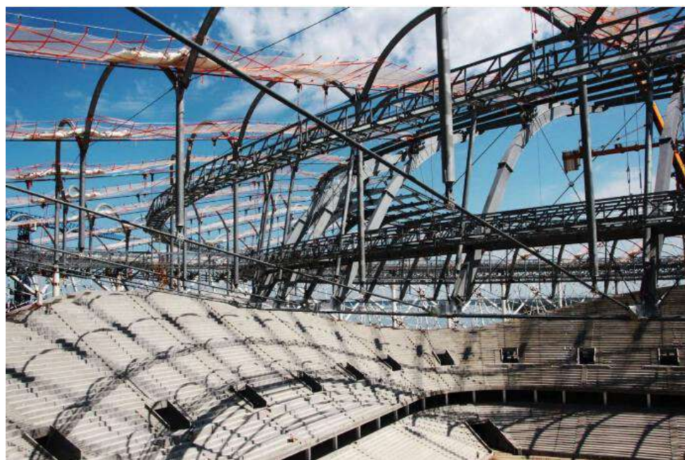
Rys. 2.18. Zdjęcie z budowy stadionu w Wołgogradzie przedstawiające zamontowane konsole, pomosty techniczne oraz podkonstrukcje pod instalacje – Etap VI [17]
