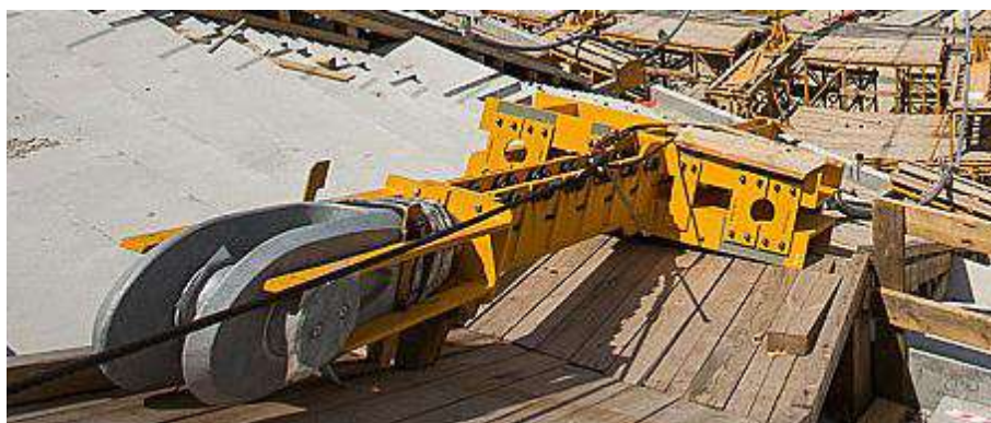
Rys. 2.13. Zdjęcie z budowy stadionu w Wołgogradzie przedstawiające wciągarkę naciągającą cięgna – Etap IV [17]
