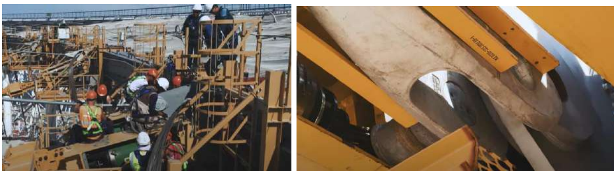
Rys. 2.16. Zdjęcie z budowy stadionu w Wołgogradzie przedstawiające łączenie cięgien z pierścieniem ściskanym [17]
