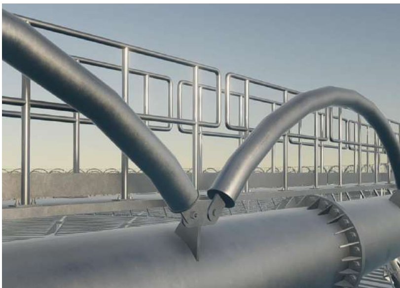
Rys. 3.97. Wizualizacja węzła łączącego łukowe profile z pierścieniem środkowym – Etap VI
