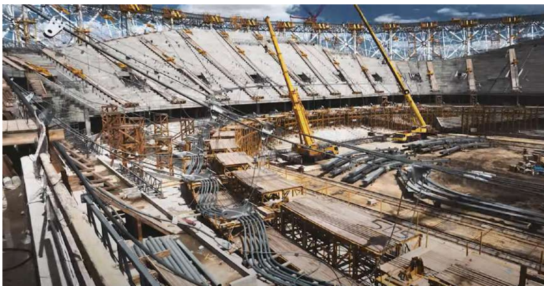
Rys. 2.10. Zdjęcie z budowy stadionu w Wołgogradzie przedstawiające proces podnoszenia / naciągu pierścienia górnego – Etap III [17]
