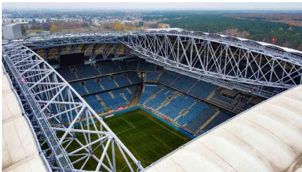
Rys. 1.7. Zdjęcie ukazujące konstrukcję dachu Stadionu Miejskiego w Poznaniu [23]
