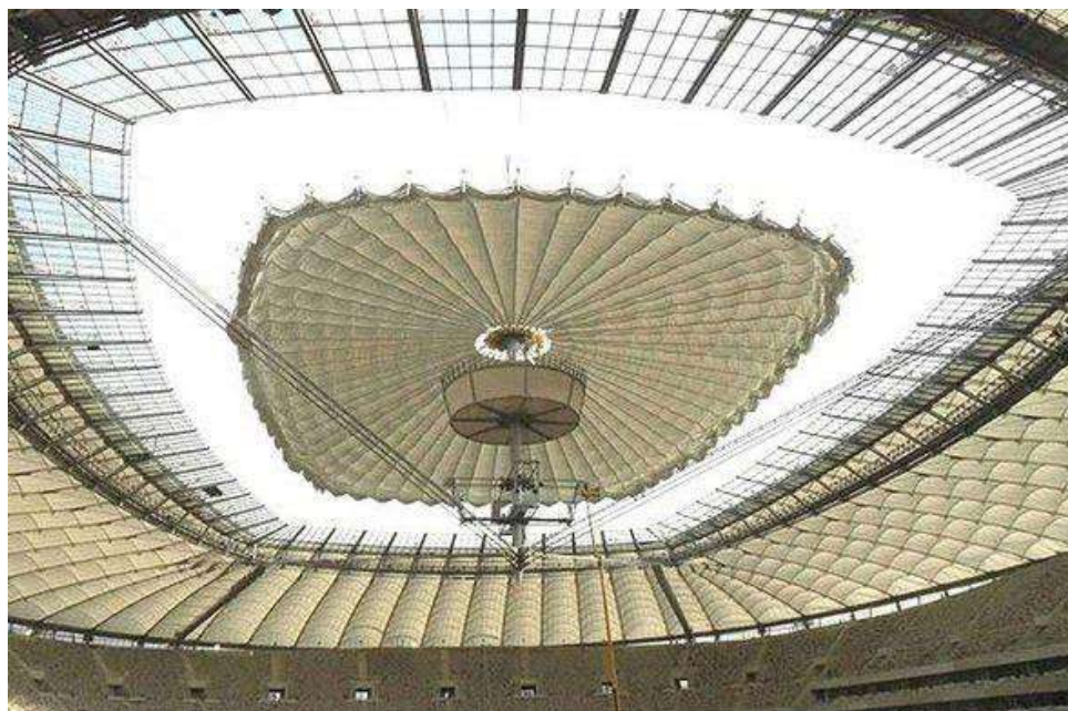
Rys. 1.23. Zdjęcie przedstawiające przekrycie Stadionu Narodowego w Warszawie podczas składania [22]
