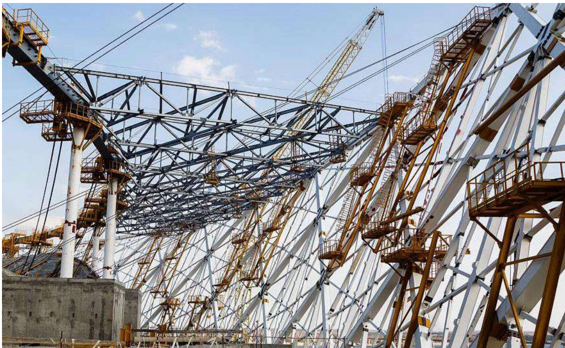
Rys. 2.8. Zdjęcie z budowy stadionu w Wołgogradzie przedstawiające montaż kratownic dachowych – Etap II [26]
