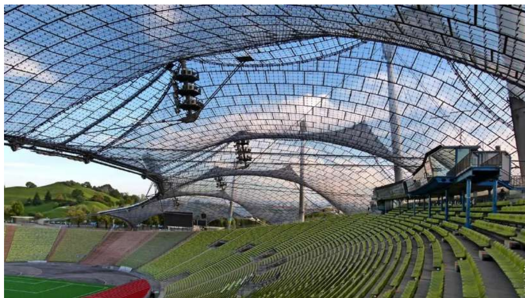
Rys. 1.19. Zdjęcie przedstawiające wnętrze obiektu Olympiastadion, Monachium, Niemcy [12]
