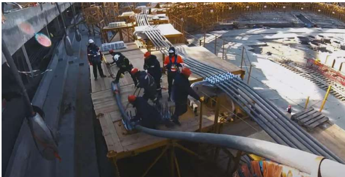
Rys. 2.9. Zdjęcie z budowy stadionu w Wołgogradzie przedstawiające pracowników układających cięgna pierścienia górnego na trybunie – Etap III [17]
