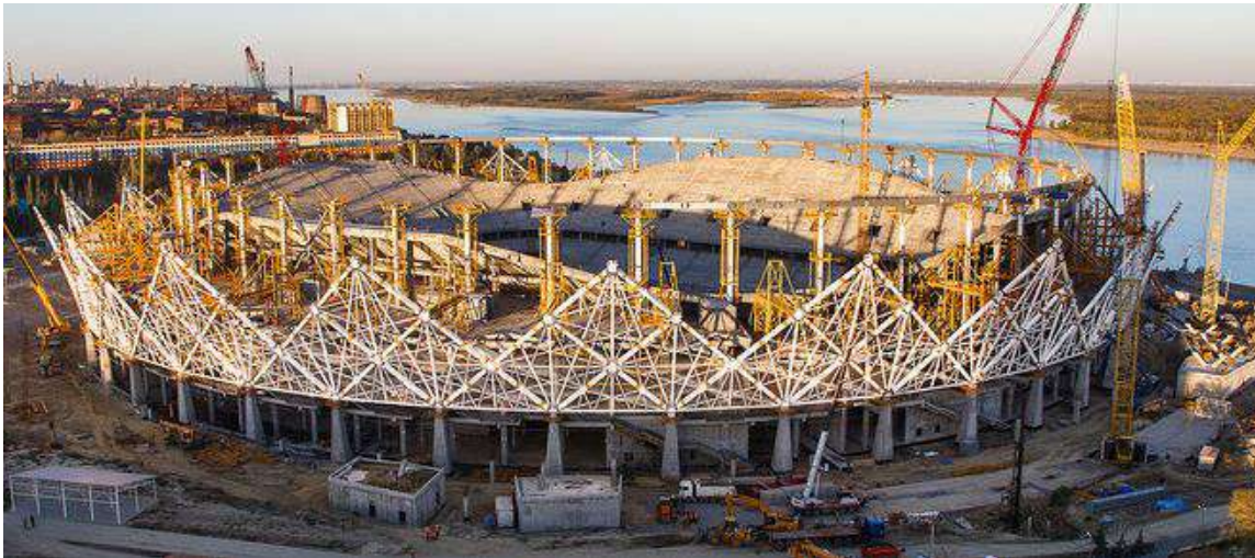
Rys. 2.7. Zdjęcie z budowy stadionu w Wołgogradzie przedstawiające montaż elementów stalowej fasady – Etap II [19]
