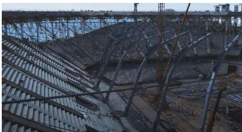
Rys. 2.15. Zdjęcie z budowy stadionu w Wołgogradzie przedstawiające naciąg cięgien [17]
