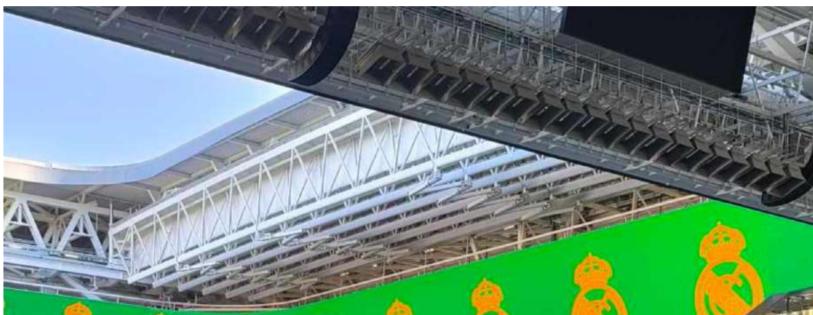
Rys. 1.21. Zdjęcie przedstawiające konstrukcję składanego przekrycia na stadionie Santiago Bernabéu w Madrycie, podczas gdy dach jest otwarty [zdz. autorskie]
