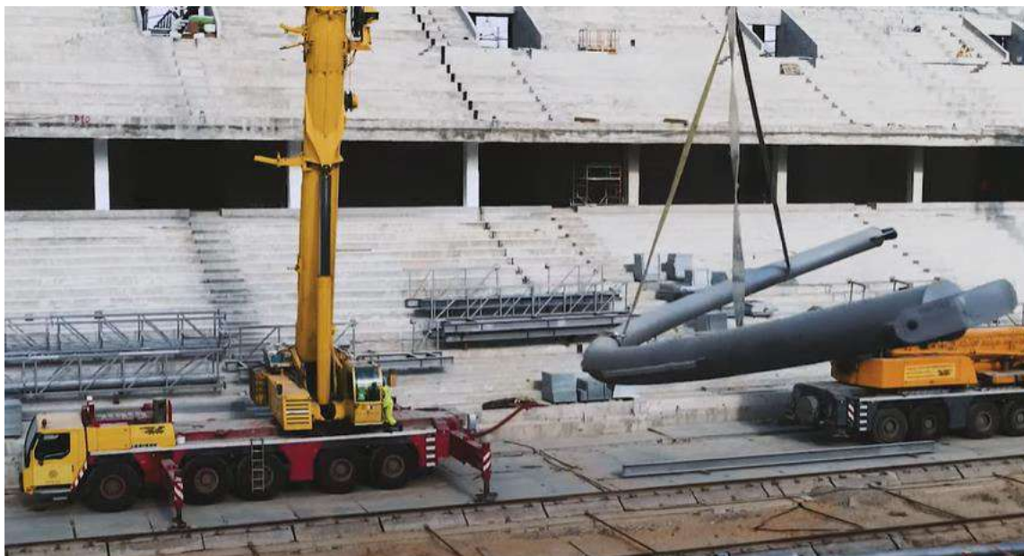
Rys. 2.17. Zdjęcie z budowy stadionu w Wołgogradzie przedstawiające montaż konsoli podpierającej membranę – Etap VI [17]
