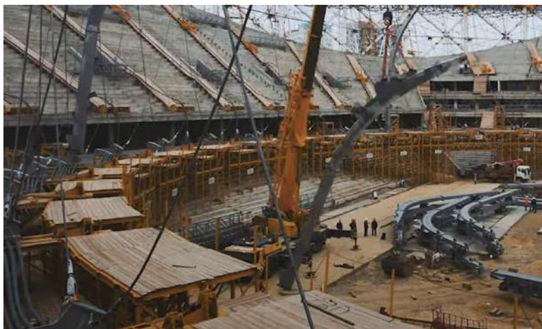
Rys. 2.11. Zdjęcie z budowy stadionu w Wołgogradzie przedstawiające montaż belek łączących pierścień dolny z górnym – Etap IV [17]
