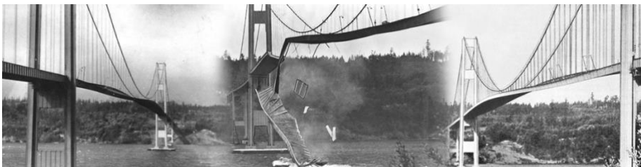
Abb. 2.21: Einsturz der Tacoma-Bridge in Folge dynamischer Windeinflüsse, in Washington, 1940 (AdSimuTec GmbH, 2024)
