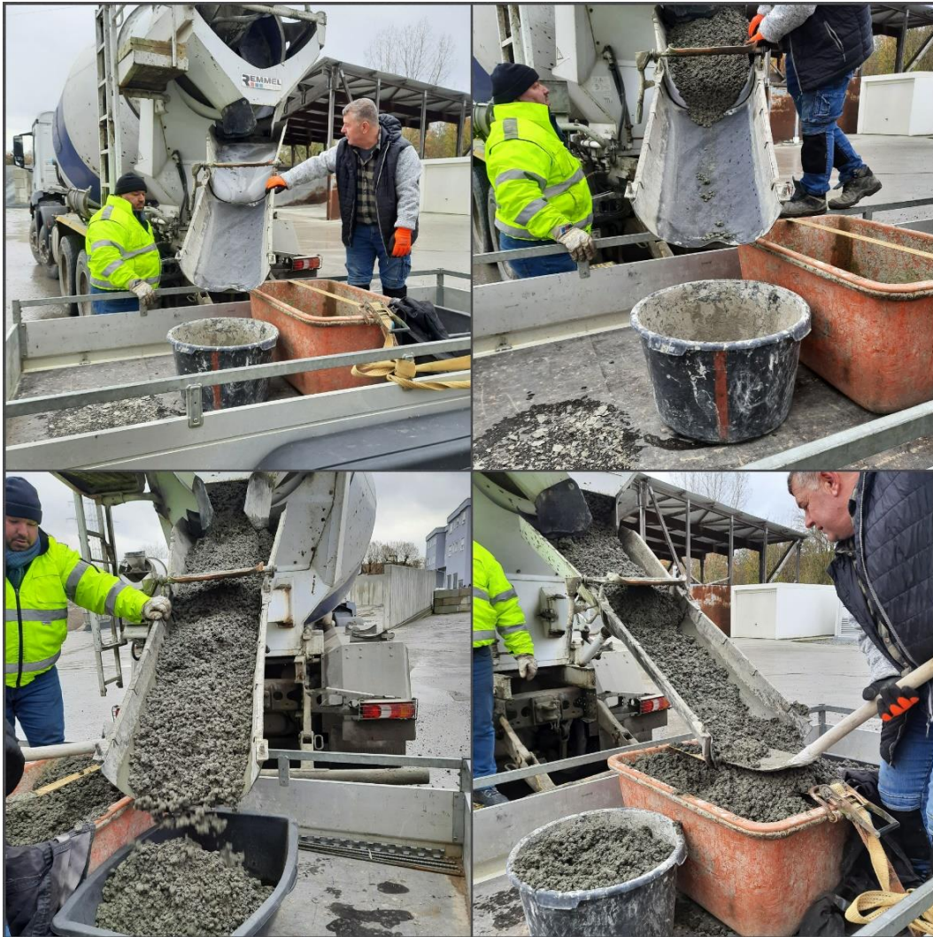
Abbildung 4.7: Einbringen des Betons vom Fahrmischer in Betonkübel
