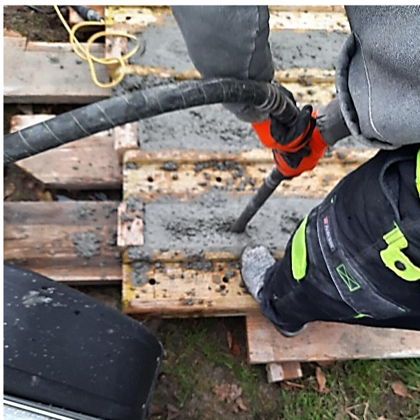
Abbildung 4.8: Verdichten des Betons
