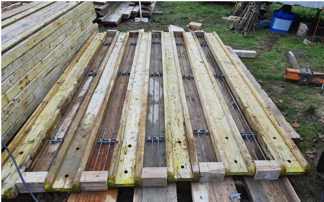
Abbildung 4.6: Schalung mit eingelegter Bewehrung
