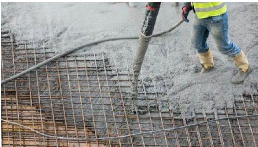
Abbildung 21: Erstellung einer Stahlbetonplatte (Das Haus Online)
